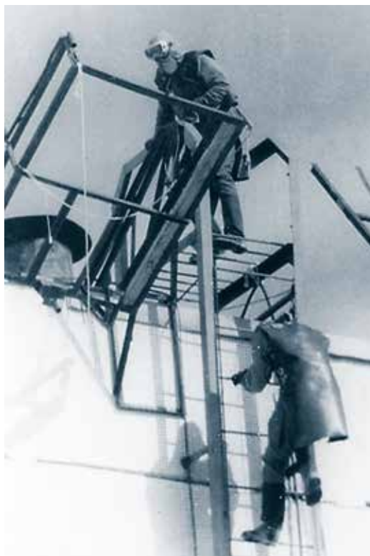
Нелегко был путь на крышу ЧАЭС в защитных доспехах
